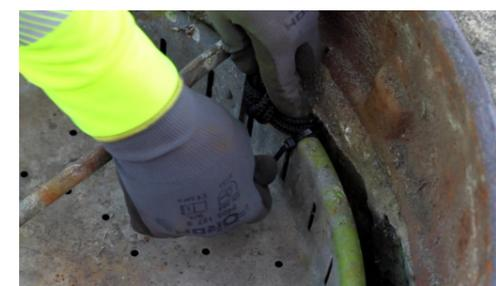
8. Befestigungsseil straffen (die Rattenköderbox muss auf der Berme stehen bleiben) und am Schmutzfänger oder einem Steigeisen mittels des mitgelieferten wiederverschließbaren Kabelbinders befestigen
